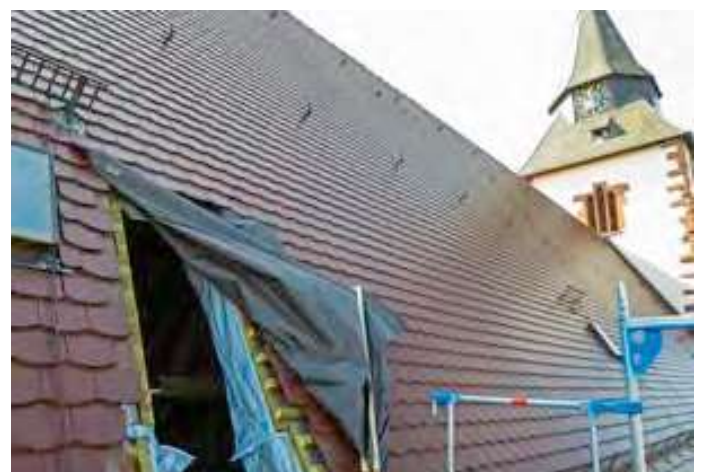
Ungewohnte Ausblicke auf den Kirchturm wurden durch die Öffnungen für die Zimmerleute möglich.
