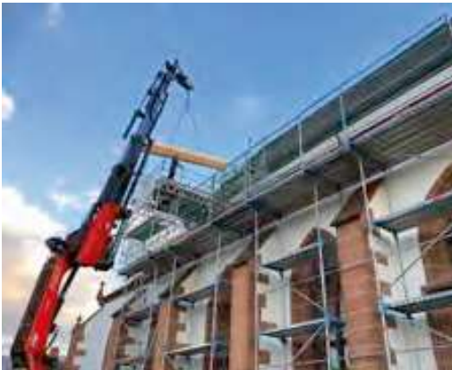
Die Anlieferung der Hölzer erfolgte über Öffnungen im Kirchendach.
