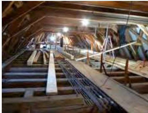
Die Baustelle der Zimmerleute befand sich über Wochen über dem mehrstöckigen Dachgerüst der Liebfrauenkirche.
