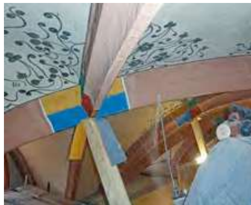
Der Steinmetz setzt Gewindestangen, die Löcher wurden durch das Kreuzgerippe in das Gewölbe gebohrt.
