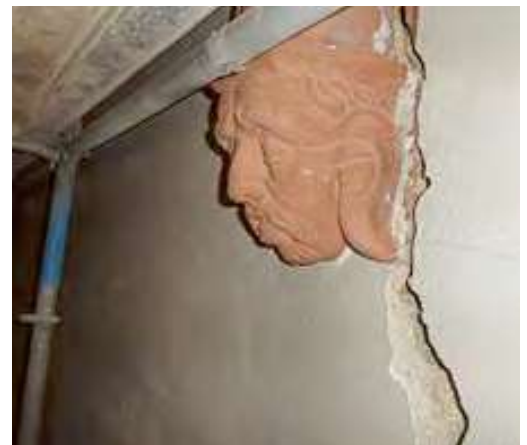
Die statischen und baulich bedingten Risse wurden bis auf das Mauerwerk geöffnet.
